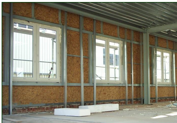
Обшивка каркасов строений
